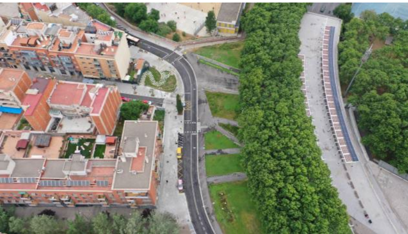
Vista Sud de les obres executades
