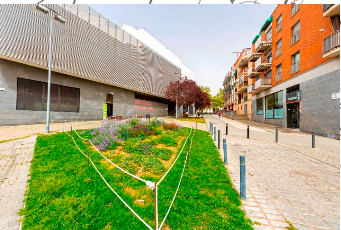
Vistes de les obres finalitzades
