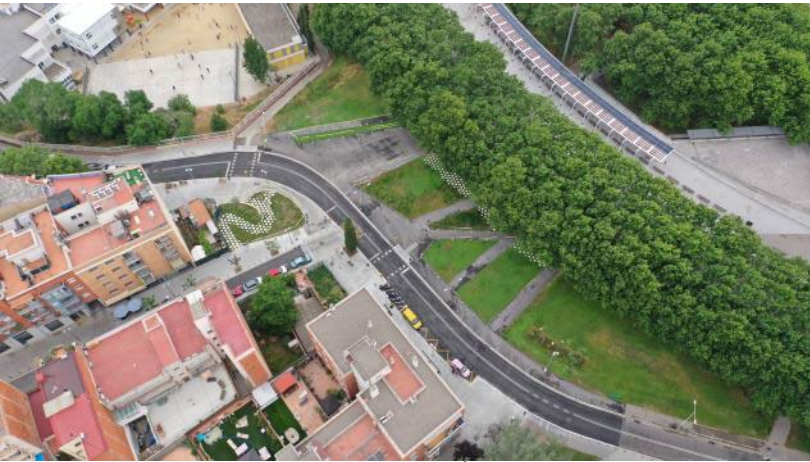
Vista est de les obres executades
